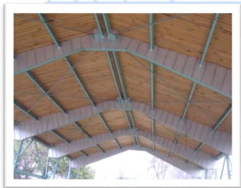
La fotografía de la izquierda muestra galpón con cerchas que fueron recubiertas con plancha metálica galvanizada para evitar el ingreso al interior de ellas y así evitar la presencia de palomas y anidación.
