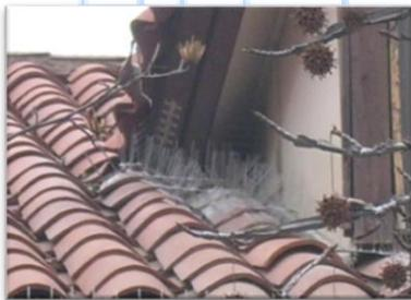
Los costados de las ventanas de mansardas también cumplen un doble propósito puesto que se protegen de los elementos y les es posible entrar al entretecho subiendo por los costados hasta el final, en que usualmente existe una abertura que les permite ingresar al entretecho. La fotografía muestra costado de ventana protegida con pinchos para evitar esto.
